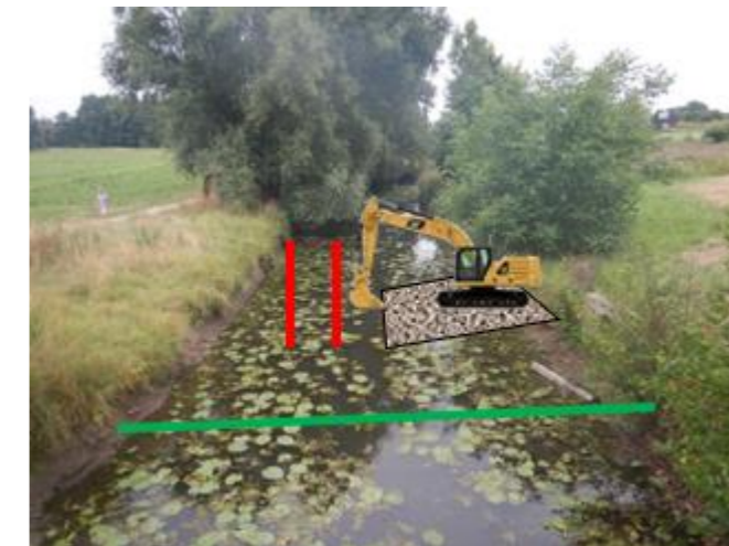
Figure 7 - Schéma explicatif du remblai mis en place en cas d'intervention depuis la rive gauche uniquement
